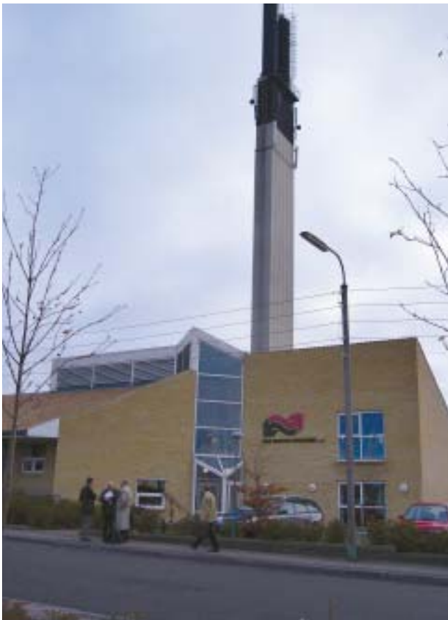
D.7 Høje Taarstrup heating plant and head office
